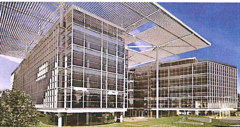
Perseo Expo District (progetto Gorina & Straia Studio) è stato completato nel 2010 a Pero (Milano): si è aggiudicato il «Mattone d'Oro 2009» quale miglior progetto di edilizia sostenibile.
