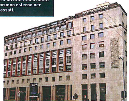
Completato nel 1939 su progetto di Emilio Lancia, il Palazzo del Toro è un edificio a destinazione mista recentemente ristrutturato con l'inserimento di impianti pompe di calore.
