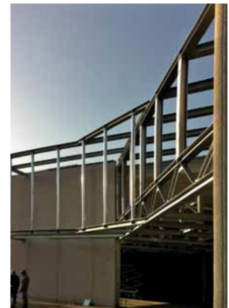
una fase del cantiere: le strutture in carpenteria metallica (foto © Terreni).
